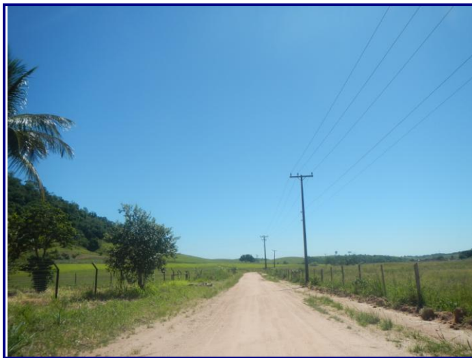
Foto 5.5.6-9: REDE DE DISTRIBUIÇÃO DE ENERGIA ELÉTRICA FONTE: ECOLOGUS, 2018
