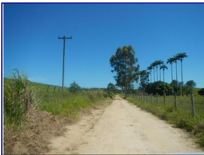
Foto 5.5.6-1: ESTRADA LOCAL DE ACESSO À ÁREA DA UTE NOSSA SENHORA DE FÁTIMA FONTE: ECOLOGUS, 2018
